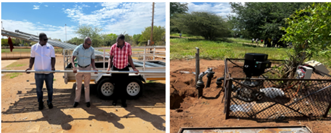
Tsumeb Smelter 在 J.P. Ratledge 体育场交付水管并安装电动水泵
