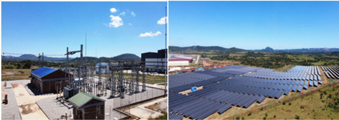
Bikita 132kv 变电站工程项目及 16.5MW 光伏发电项目
