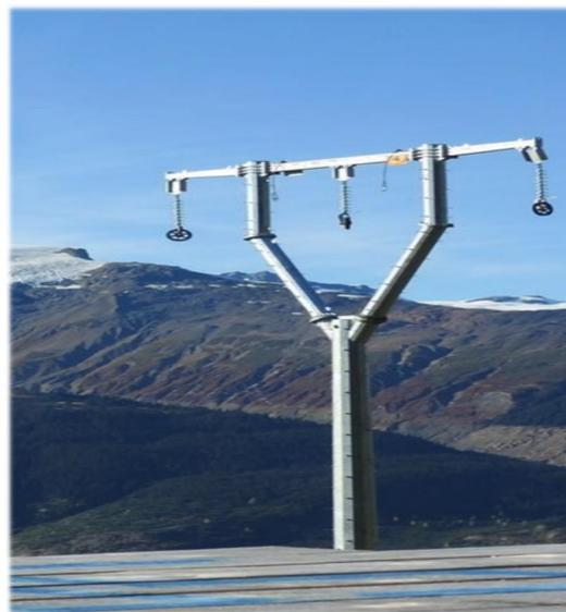
3、变电站构架：变电站是电力系统中变换电压、接受和分配电能、控制电力的流向和调整电压的电力设施，它通过其变压器将各级电压的电网联系起来。在电力系统中，变电站是输电和配电的集结点。因此，变电站整体构架的性能直接影响到变电站工作效率。变电站构架主要由角钢、钢管、钢板等钢材构成，构件之间通过焊接或者螺栓连接，构架连接节点比较复杂，一般采用柱头形式或者法兰形式，要求外观美观，应用于变电站内各种设备和导线之间的支撑。
