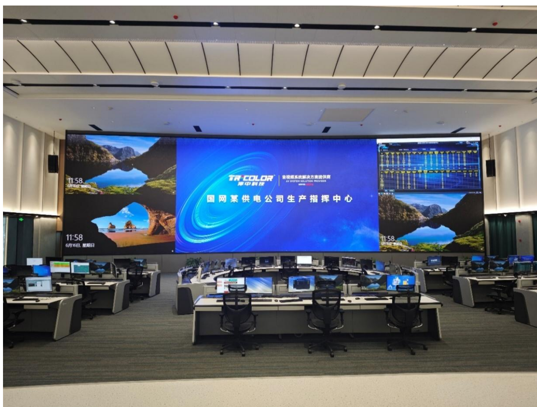
某生产指挥中心项目
