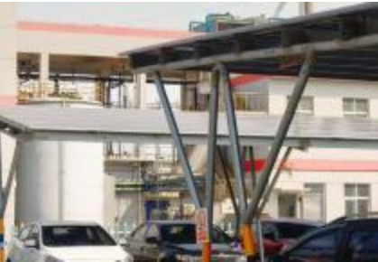
南通泰禾光伏发电
