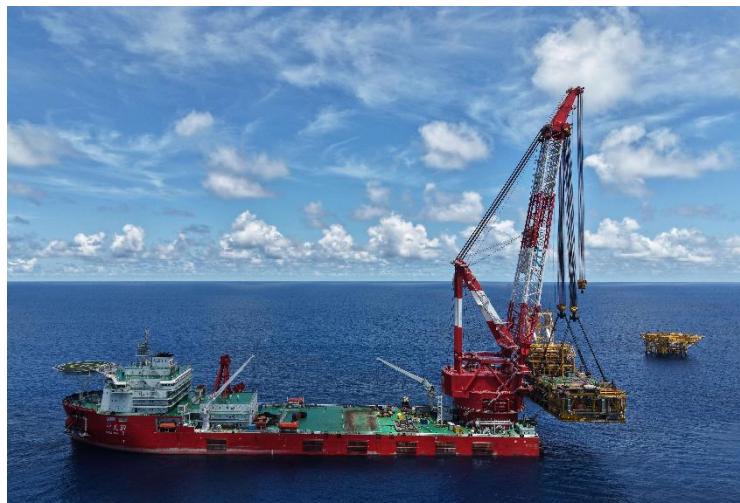
图：越南油田模块安装项目
