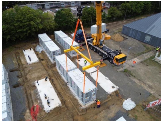
图：德国电信 24MWh 项目吊装现场
