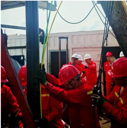
图：耐温 200℃、耐压 200Mpa 套管外油井光缆项目施工现场
