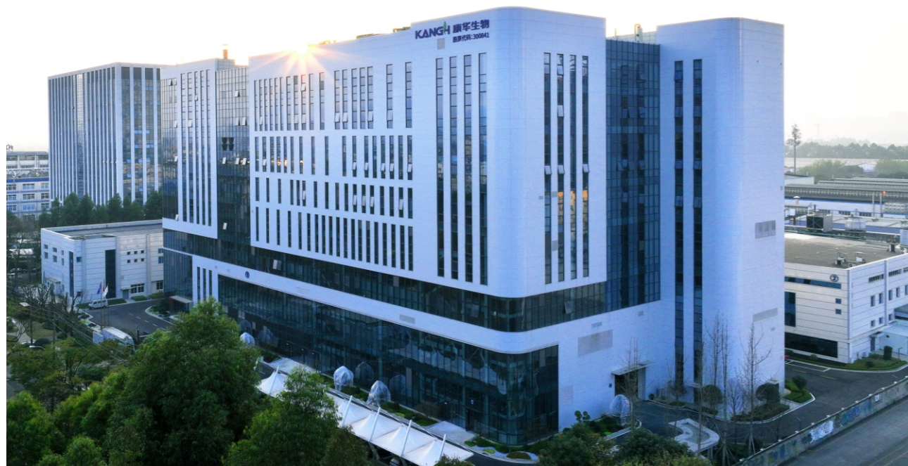
成都康华生物制品股份有限公司龙泉驿厂区
