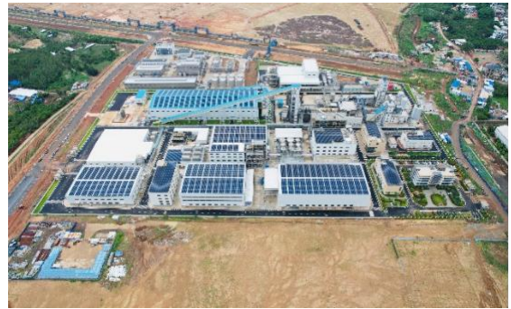
海南 2 万吨氢氧化锂项目实景图
