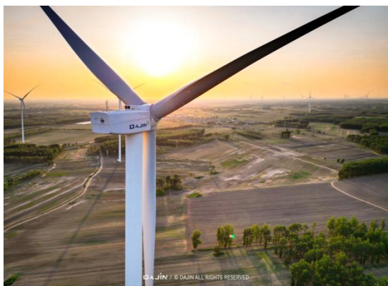
大金重工阜新彰武西六家子 250MW 陆上风电项目
