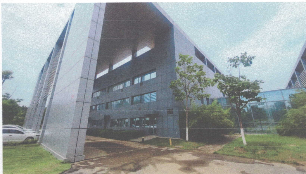
惠河路-90-2 号固体制剂车间
