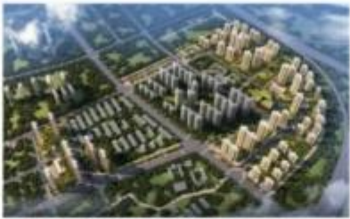
■ 武汉蔡甸中法生态城新天地还建 区装配式项目(PC)
