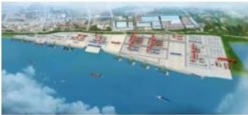
中铁二十二局武穴船舶产业园项目
