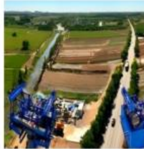
| 雄商高铁衡水枢纽站前一标项目桩基工程
