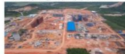
▲ 印尼宾坦动力中心地基处理工程
