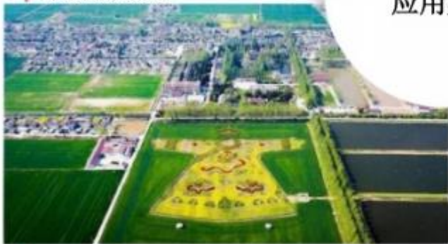
■ 中铁六合龙袍新城项目
