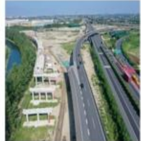
| 沪武高速扩建董浜枢纽段
