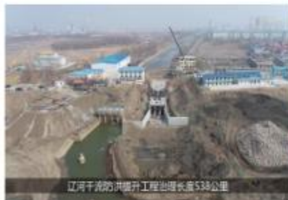
辽宁省辽河干流防洪提升工程
