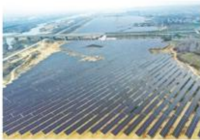
麻城市多能互补百万千瓦新能源基地项目
