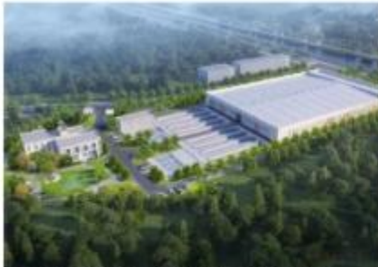
顺德区大良勒流水体综合整治工程- 优先实施子项工程（一期）工程项目
