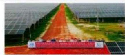
▲ 孟加拉国达门市50MWac光伏项目
