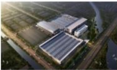
汇川新能源汽车技术(苏州)有限公司 新能源汽车零部件生产基地项目
