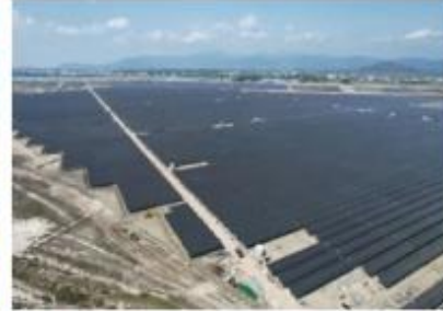
莺歌海盐场100MW平价光伏项目
