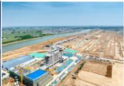
周口港中心港区中心作业区（一期）
