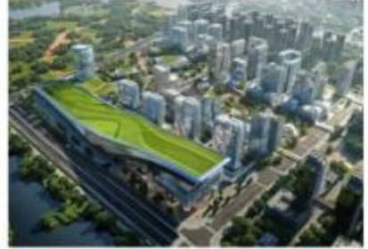
| 深圳前海. 冰雪世界基坑支护及桩基础工程
