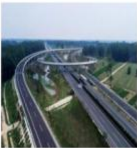
| 阜溪高速公路建湖至兴化段
