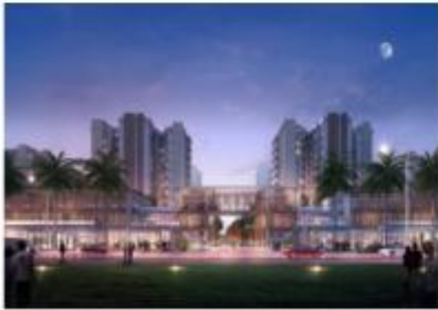
| 广州花都花山安置房项目桩基工程
