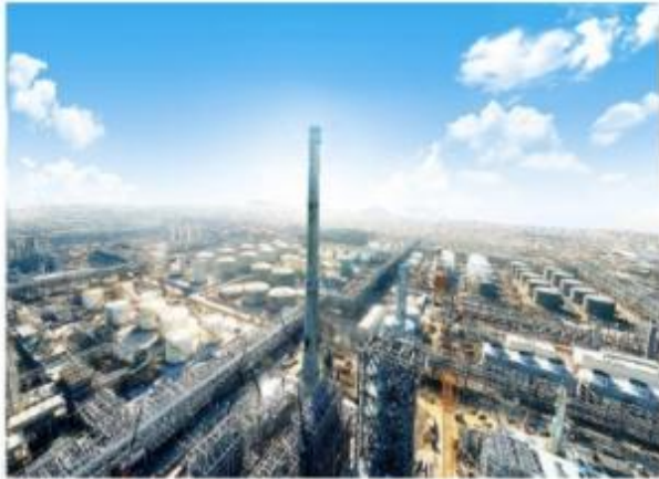
浙石化年产4000万吨炼化一体化项目
