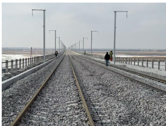
公司轨道扣件产品应用场景示意图 (包银高铁建设现场情况)
