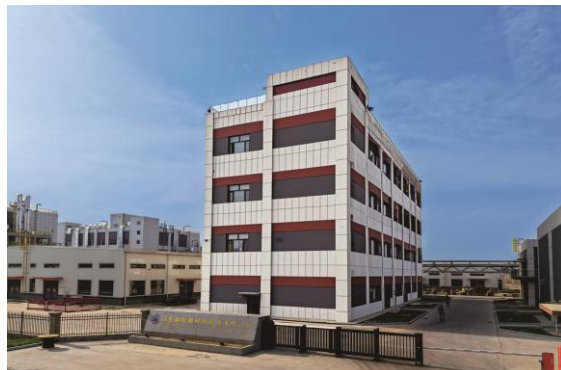
2025 年 6 月子公司山东瑞纶新材料科技有限公司通过竣工验收
