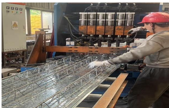
镀锌板桁架筋焊接
