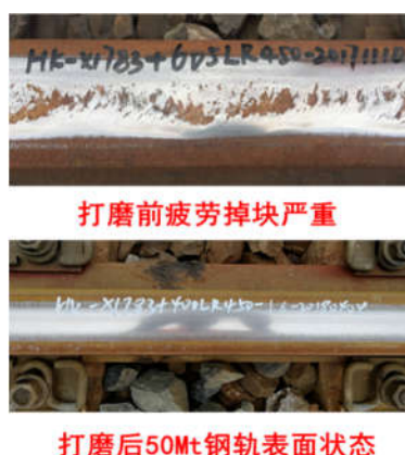
图 3：钢轨打磨前后状态对比
