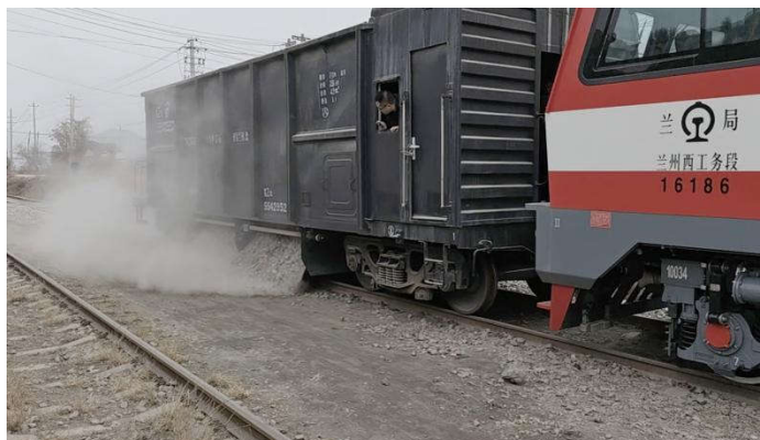
图 11 石砟漏斗车智能卸料系统
