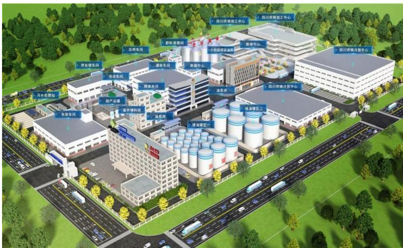
某油脂智能数字化生产基地项目：该项目建设不同产能油菜籽智能化榨油车间、浸出车间、精炼车间、小包装车间、原料筒仓；配套原料接收、清理、饼处理车间、粕包装车间及公用工程设施。充分发挥公司在油脂专业的设计优势，结合场地条件以及业主的实际需求，将油脂加工基地和食用油物流储运中心两大板块有机融合。该项目建设将进一步优化西南供销物流基地的产业链布局，促进川渝地区菜籽种植与加工等产业的蓬勃发展。
