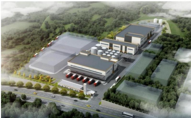
某绿色食品产业园（二期）项目：该项目涵盖建设日处理 120 吨浓香菜籽的生产车间、3 条灌装线、包装调和油罐系统、总容量 4,800m<sup>3</sup> 油罐区。同时，项目还配套建设 10t/d 污水处理站、一站式服务中心等公用配套设施。项目建设能为西部地区油脂行业引入新的原料选择，契合业主方深入贯彻落实地方各级政府“三大战略”、奋进“三大目标”和当地农业“135”工程、农业提质三年行动的目标。项目在保留油脂专业设计精髓的基础上，结合业主需求与川渝地区居民的饮食偏好，致力于打造一个在当地具有示范意义的粮油综合加工生产和物流基地。
