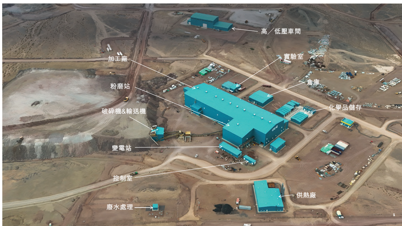
照片：二零二五年八月二十四日BKH礦場建設進度 (99.9%已竣工)
