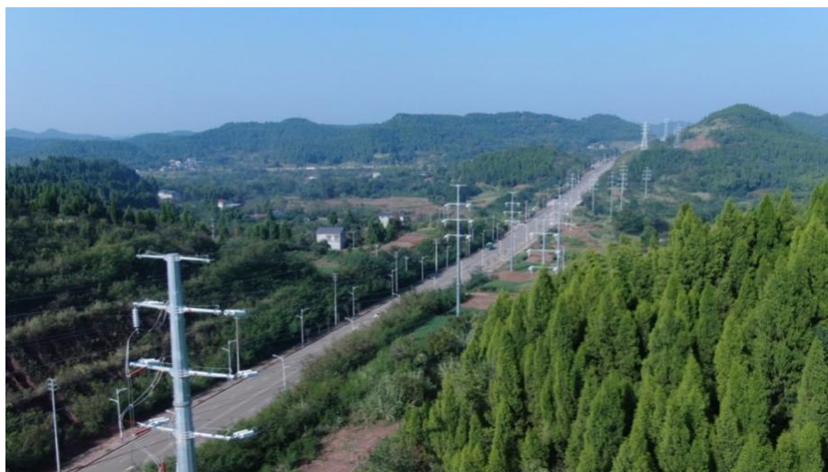
同盟至白马 110 千伏线路工程
