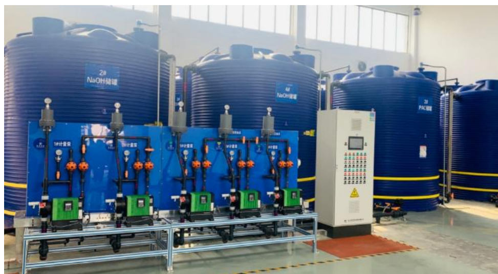
杭州临平自来水厂（2021）
