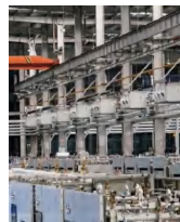
投资数百万元为生产车间安装水冷空调
