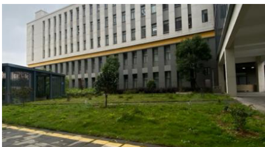
循环废水绿化喷淋系统
