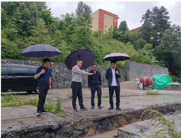
图：检查昆寨乡中心学校运动场升级建设项目
