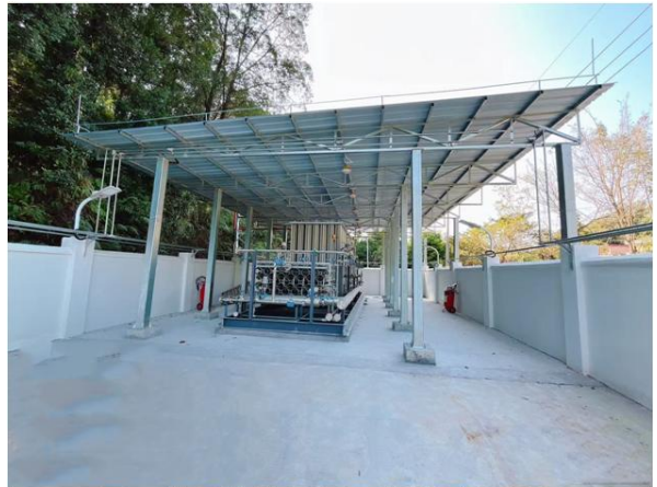
图：梯面镇燃气项目微管网气源点
