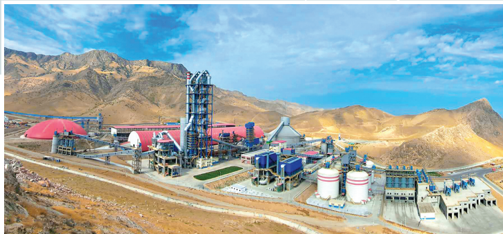
安集延西部水泥廠房，烏茲別克斯坦
