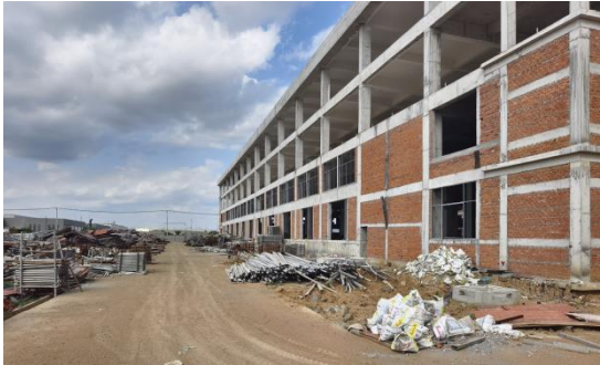
2025 年 3 月发行人越南新建厂区已经结顶
