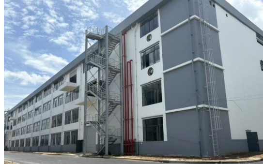
越南新建厂区近况照片
