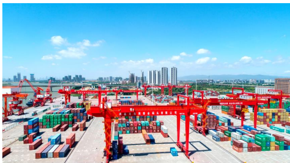
图：轨道式集装箱起重机施工实景
