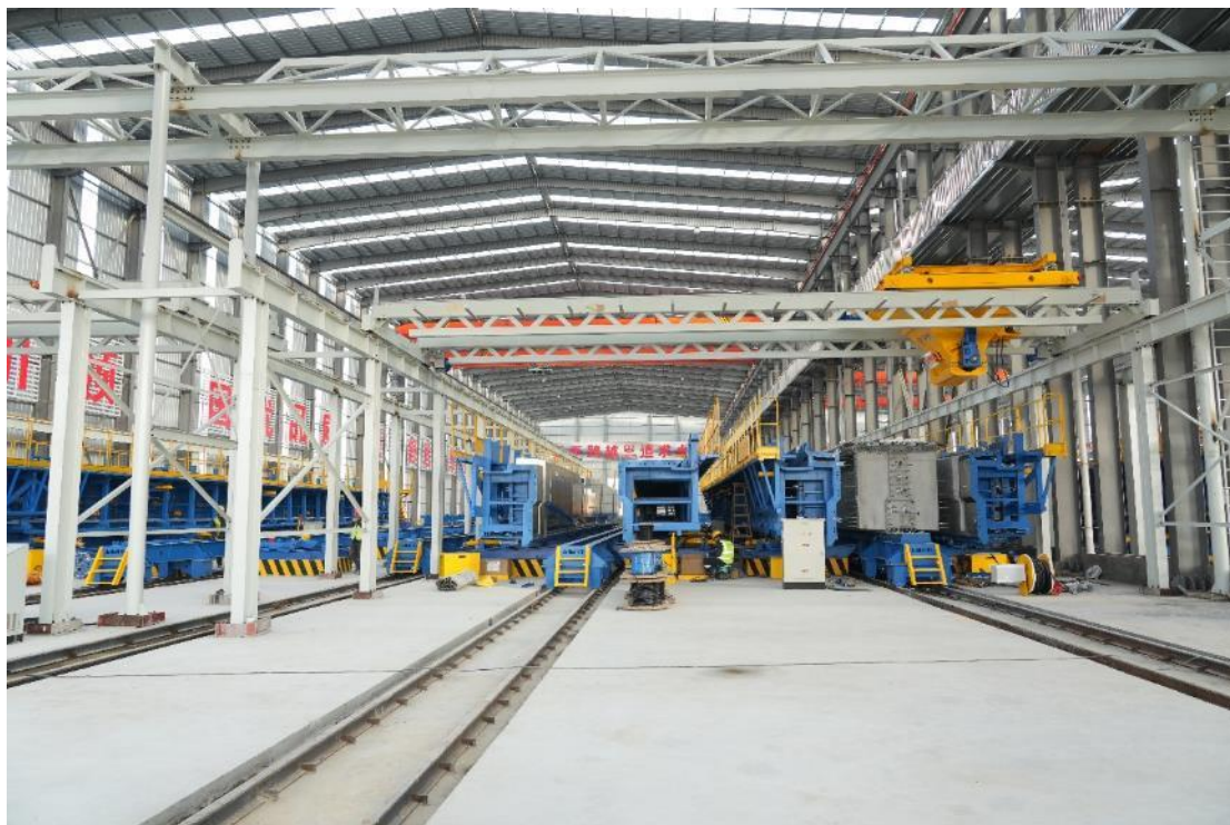
图：T 梁预制场施工实景
