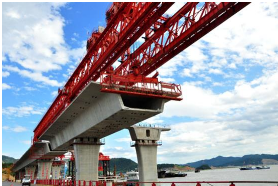
图：节段梁架设实景
