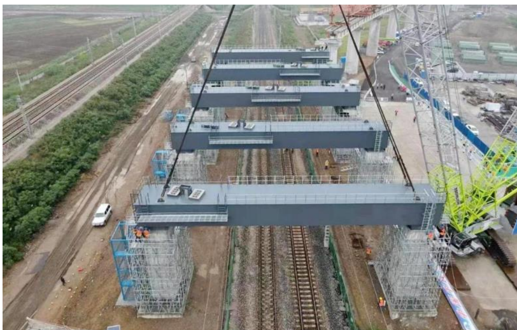
图：门式墩钢梁施工实景
