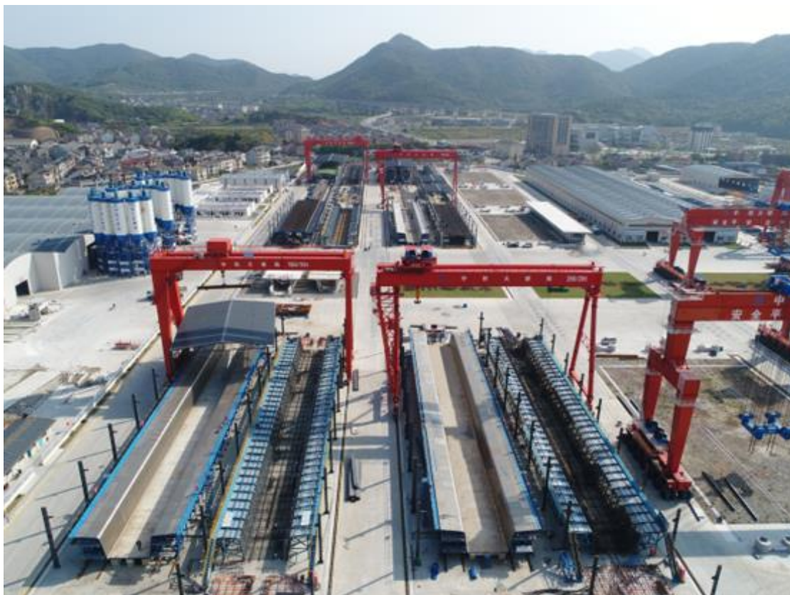
图：整孔梁预制场施工实景
