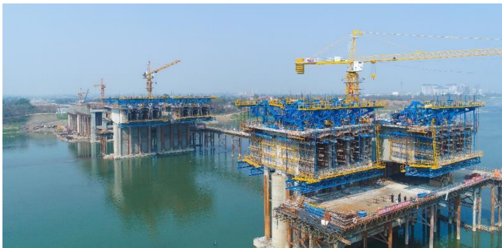
图：挂篮施工实景
