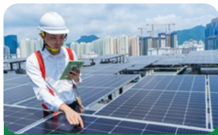
位於同力工業中心的太陽能系統
