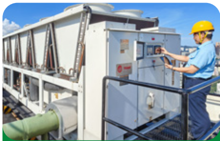
新鴻基中心的重新校驗及製冷系統優化
