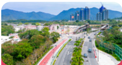
我們透過擴闊道路、興建西沙行人天橋及單車徑，改善當區基礎設施
