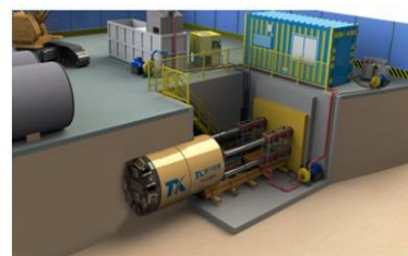
3、启动主机挖掘前方岩土，控制油缸伸出，将主机推入岩土内
