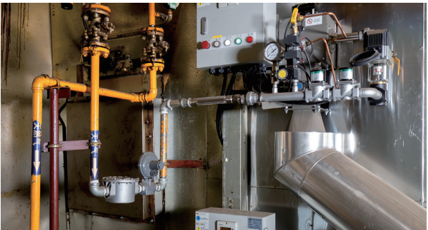
浸胶机燃烧器节能扩容改造，燃烧效率得到提升
