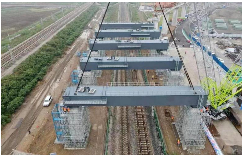
图：门式墩钢梁施工实景
