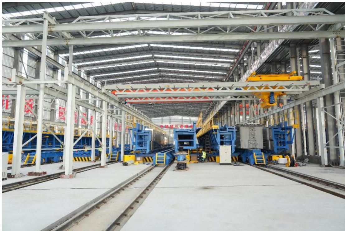
图：T 梁预制场施工实景
