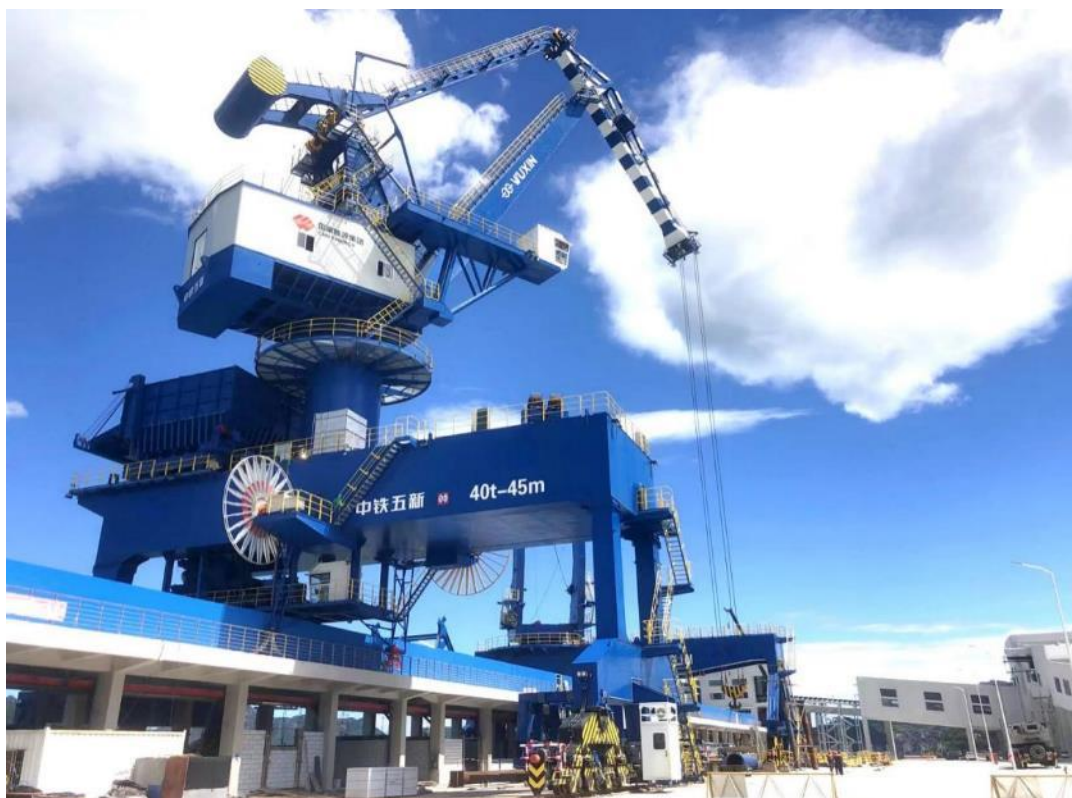
图：带斗门座起重机施工实景
