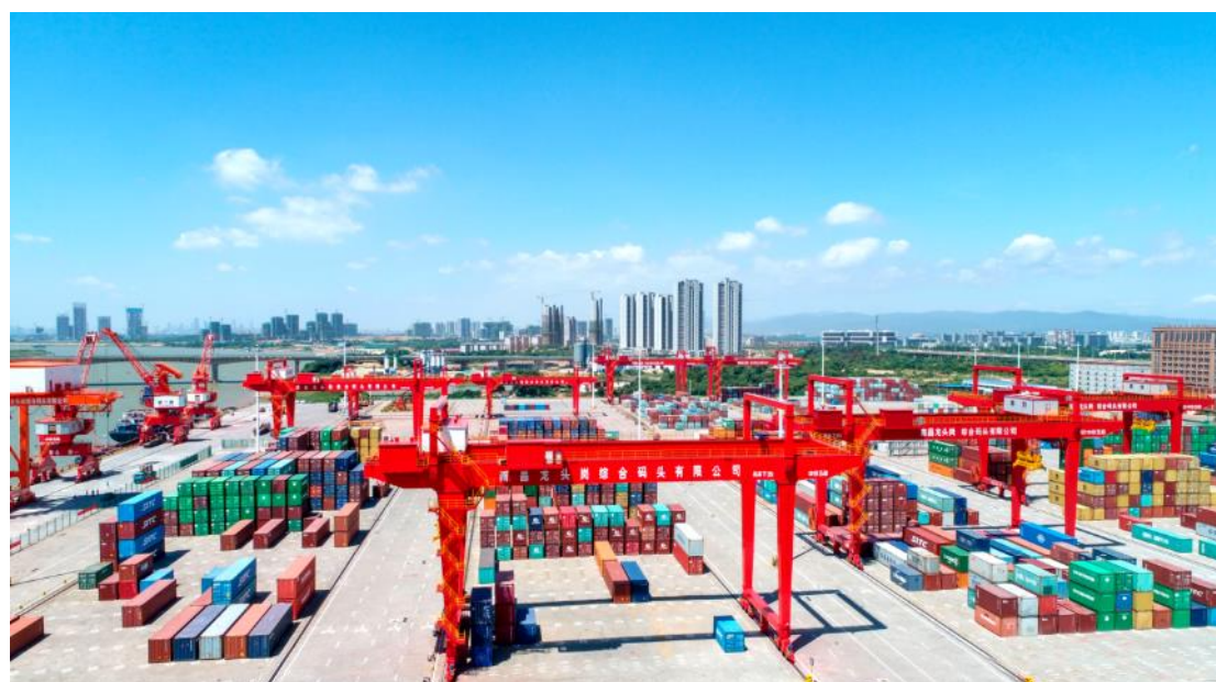
图：轨道式集装箱起重机施工实景
