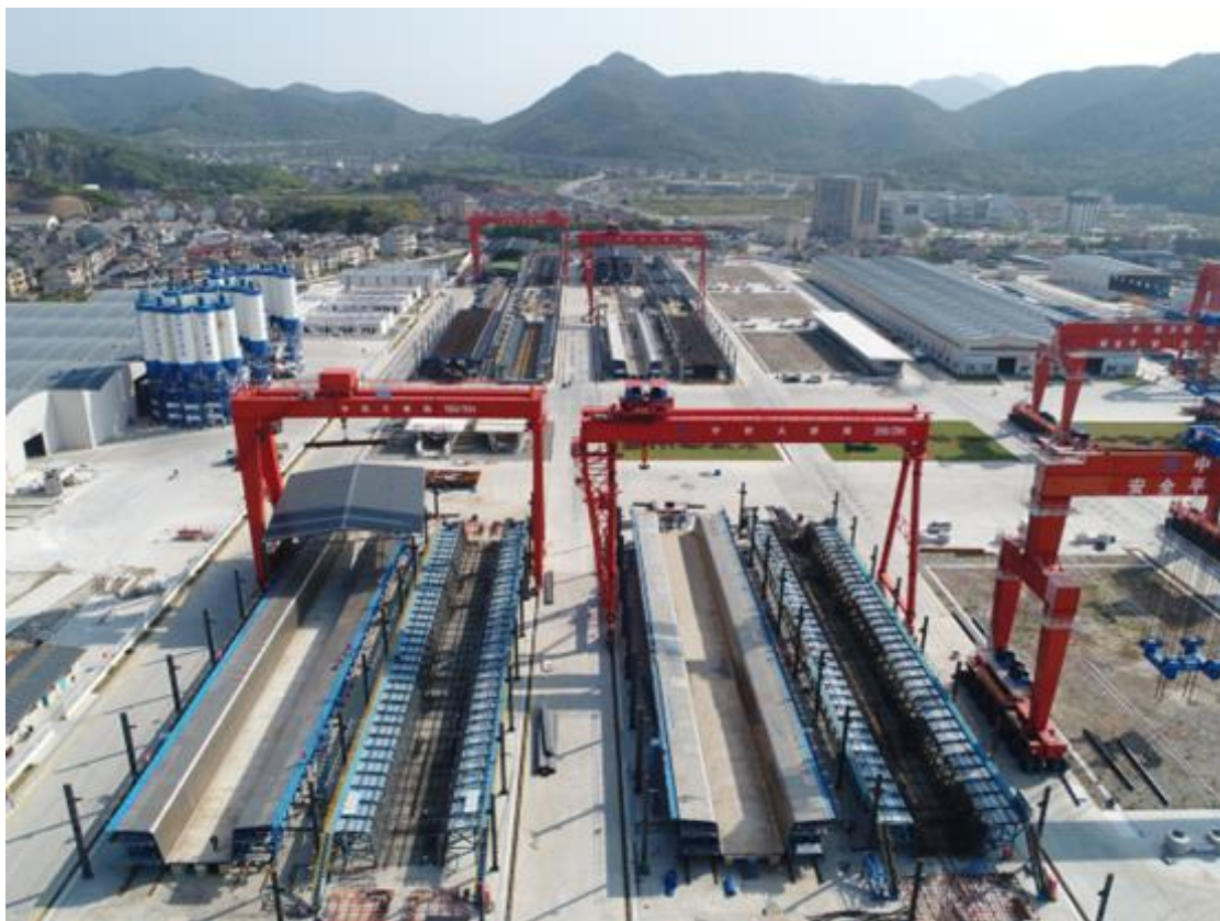
图：整孔梁预制场施工实景
