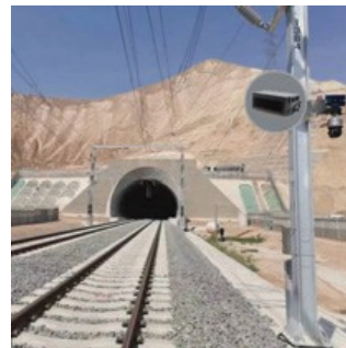
安裝在列車軌道上方
