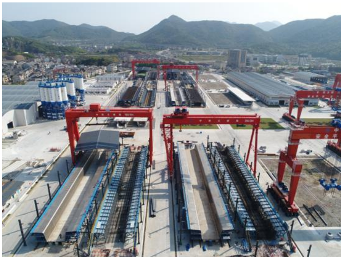
图：整孔梁预制场施工实景
