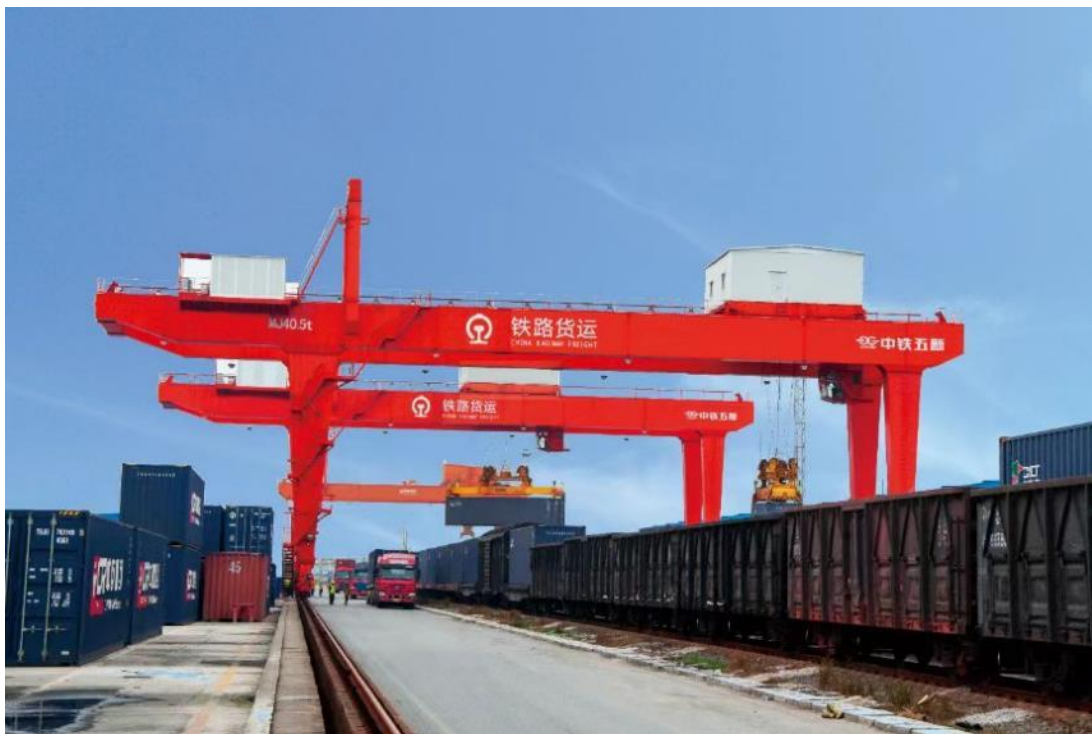
图：铁路货场门式起重机施工实景
