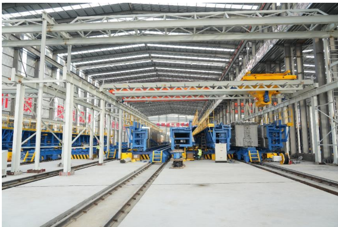
图：T 梁预制场施工实景
