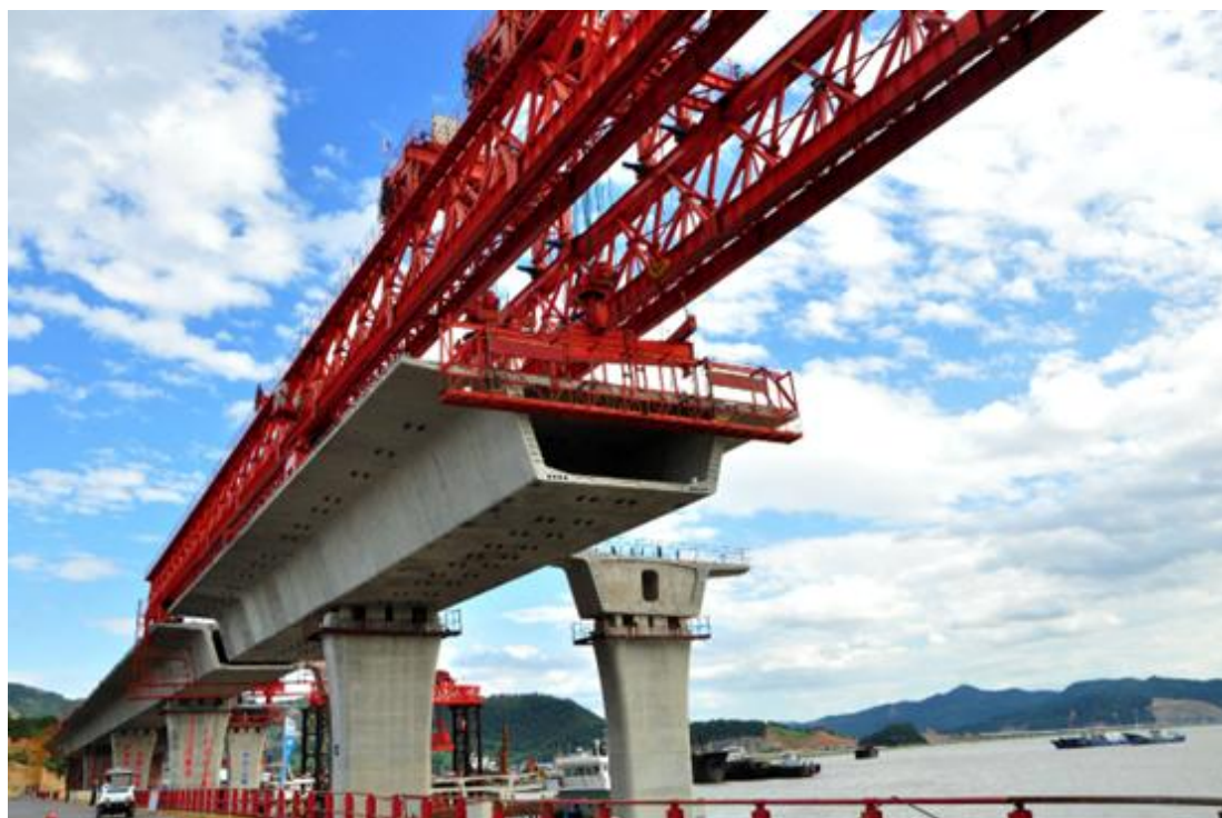
图：节段梁架设实景
