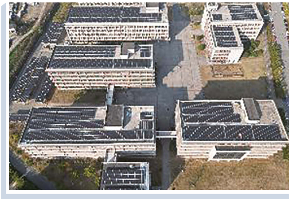
安徽學校光伏發電設施
