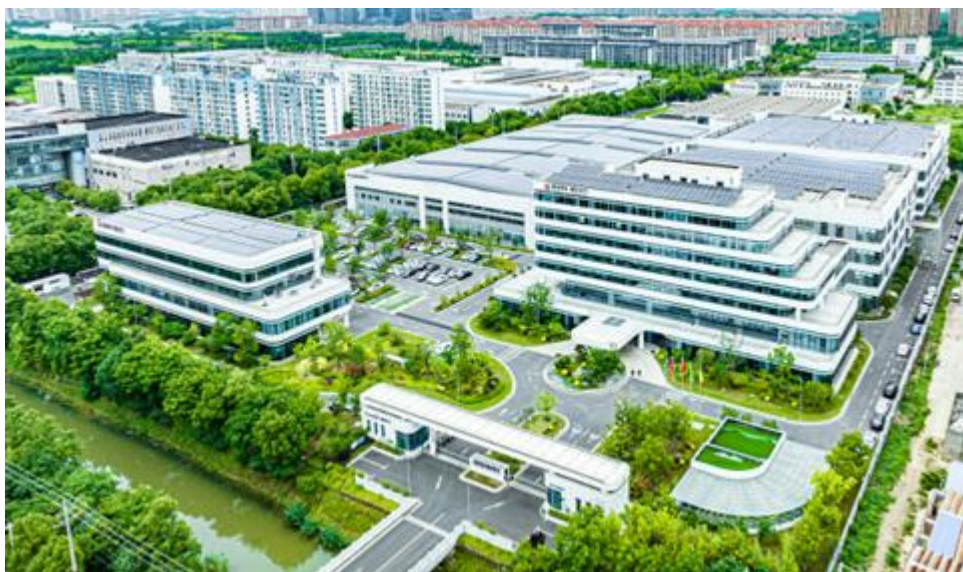
朗信电气张家港新厂区（现总部）实景图
