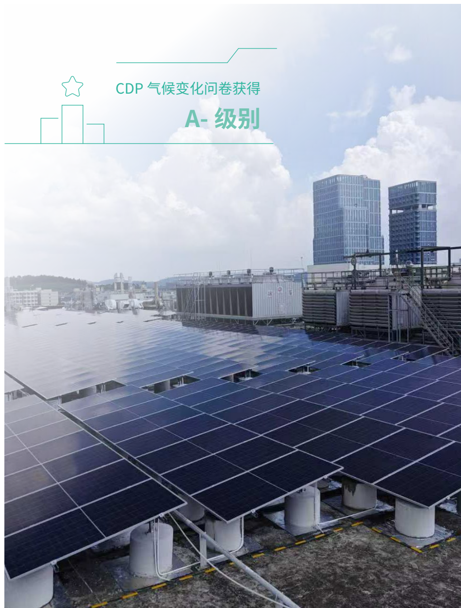
推进屋顶光伏项目建设
