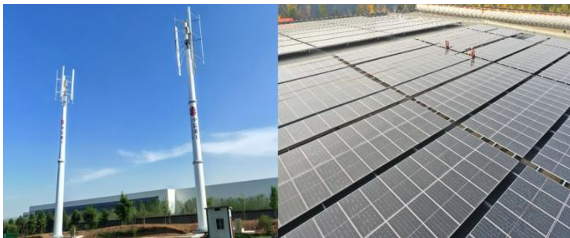
图示：垂直轴风机、源网荷储一体化示范项目
