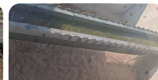
中水回用管道疏通
