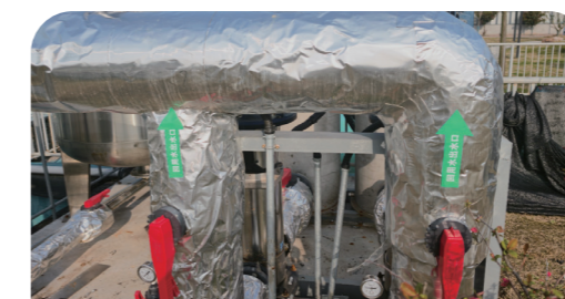
厂区内增设回收管网及水泵
