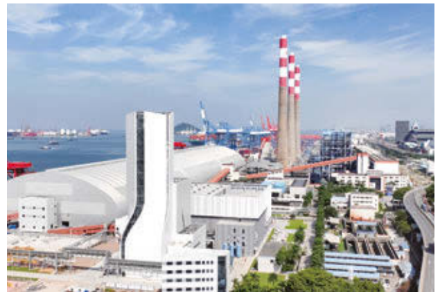
● 本行深圳市分行为妈湾电厂升级改造提供金融支持，图为妈湾电厂升级改造气电一期项目。
