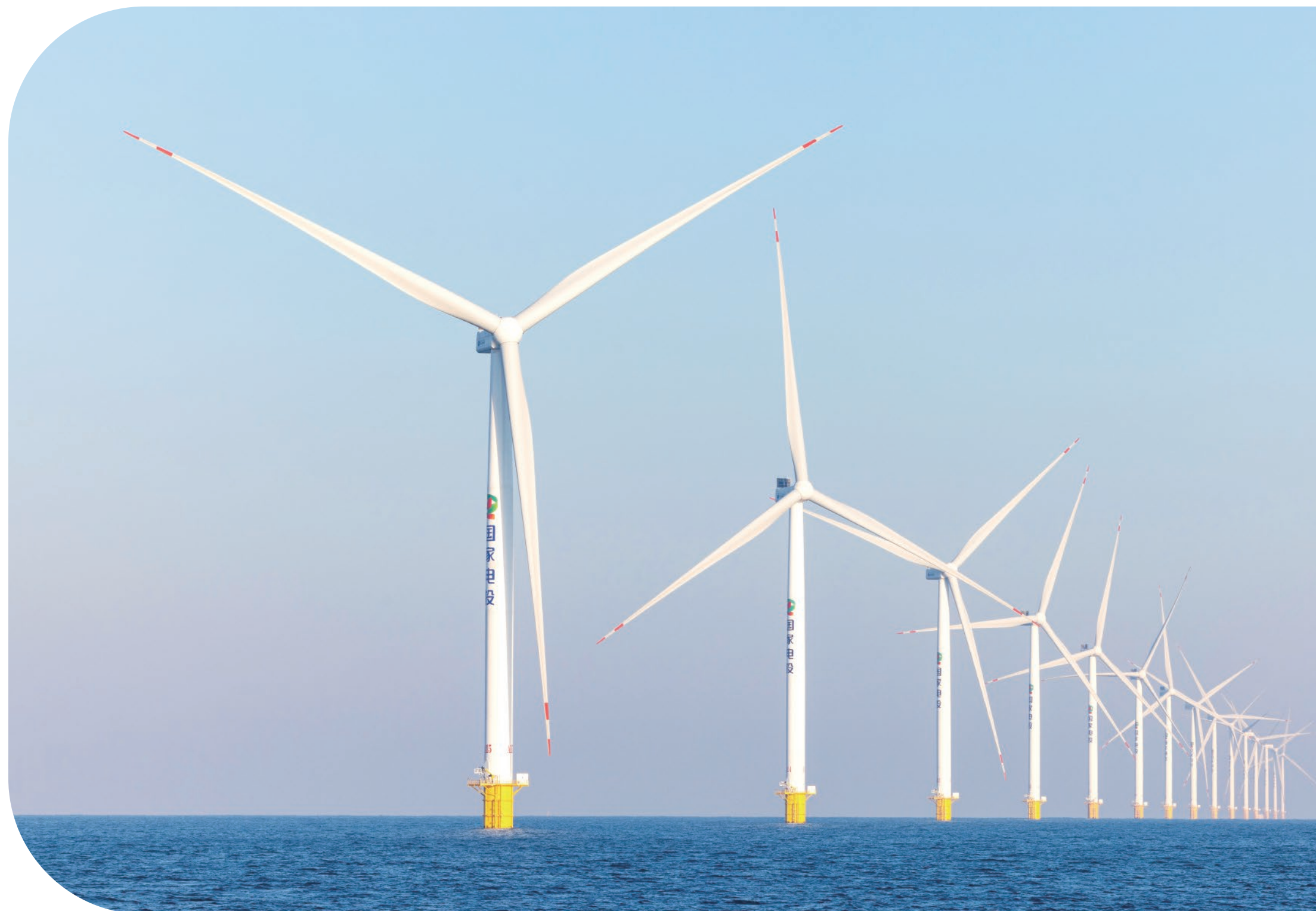
圖為國家電投山東半島南海上風電基地場景，郵儲銀行山東省分行為其一期450MW項目投放貸款5億元。
