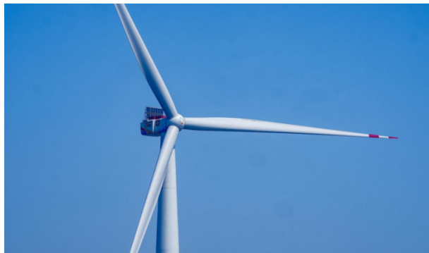
“启航号” 20MW 漂浮式海上风电机组
