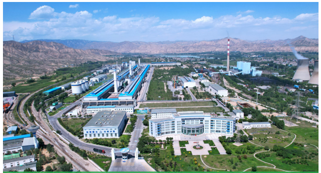
九冶連城鋁業 500KA 區域光伏項目
