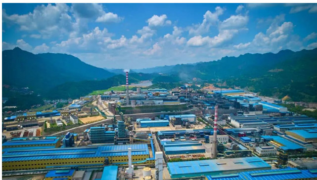
長沙院鋅基多源固廢協同資源化關鍵技術與大型化裝備建成了世界最大的複雜含鋅物料 198m 2 流態化焙燒爐
