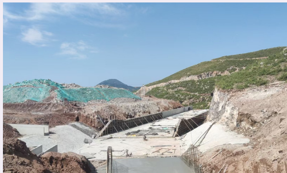
十二冶中鋁中州鋁業膏體尾礦庫閉庫項目
