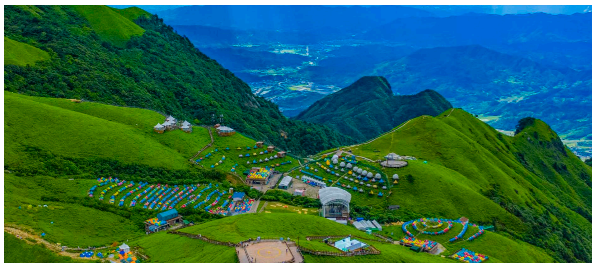
江西省分行支持萍鄉武功山 5A 級風景名勝區生態草甸修復及服務設施提升改造。
