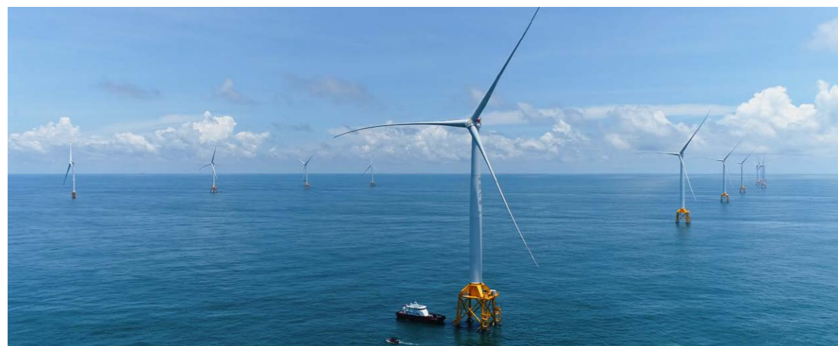
廣東省分行支持某港口海上風電場建設。
