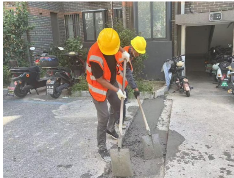
燃氣管網改造
