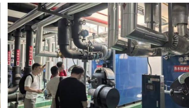
醫院低氮冷凝鍋爐改造項目現場勘察
