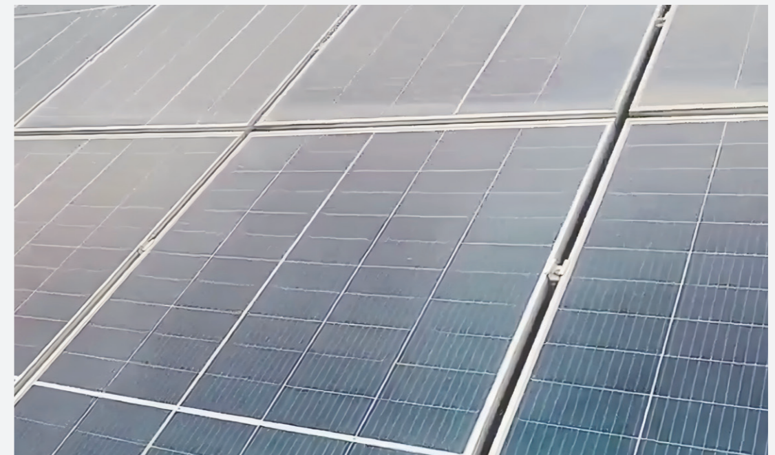
安徽博斯特铺设光伏面板
