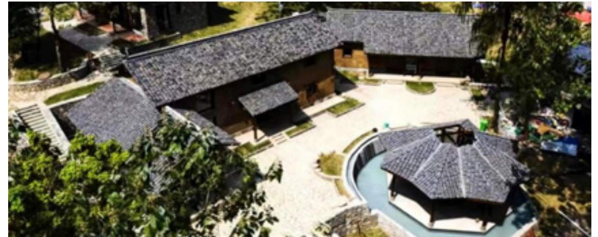
升級改造後的「下莊天路」景區
