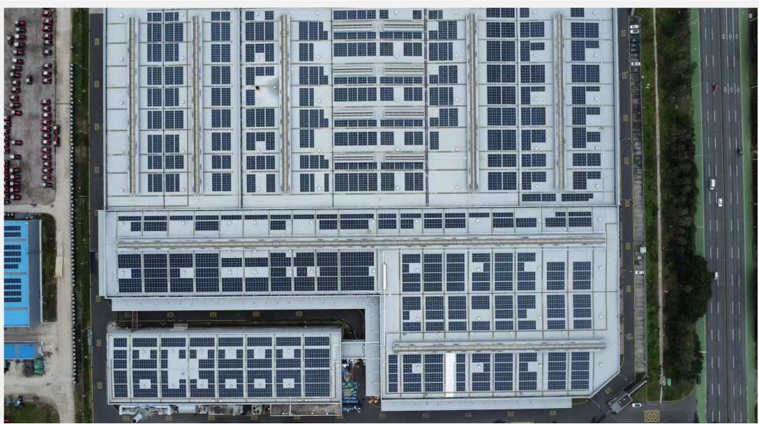
赛格威科技有限公司屋顶光伏
