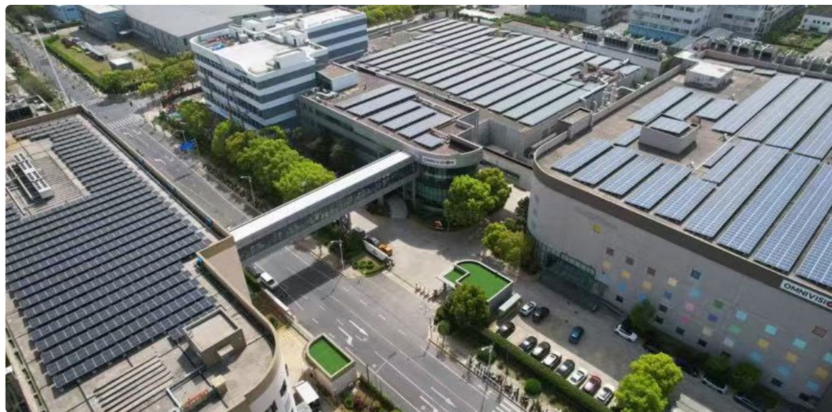
屋頂光伏發電系統
