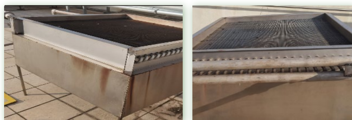
華鵬收縮爐蒸汽排放回收和蒸汽冷凝水熱量回收設備
