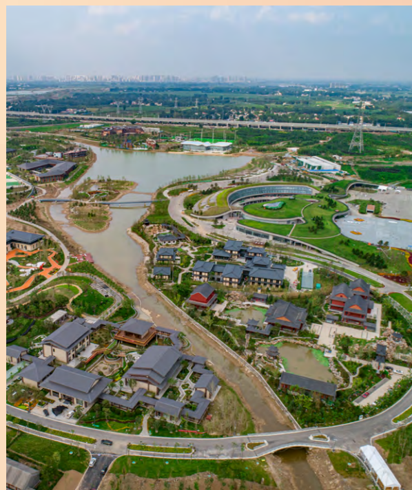
东北院主持设计的雄安园建设工程及配套设项目顺利竣工——远景
