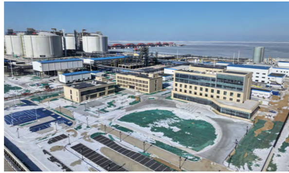
能源院营口 LNG 接收站项目主体工程完工
