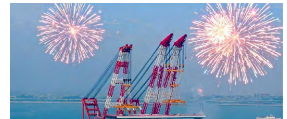
公规院主持设计的厦金大桥（厦门段）海上首榀钢箱梁成功吊装
