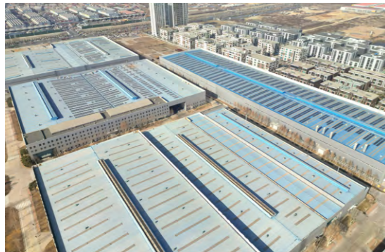
能源院设计的石家庄煤矿机械公司分布式光伏发电项目
