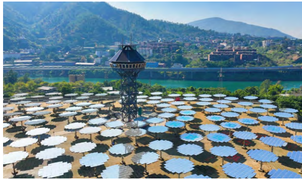
西南院设计的全球首个光解水制氢商业化项目正式竣工投运
