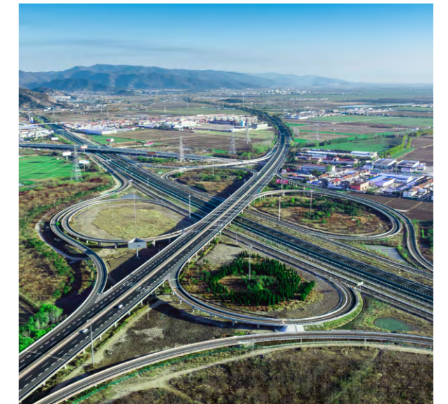
二公院设计的长深高速连淮段扩建工程通过交工验收
