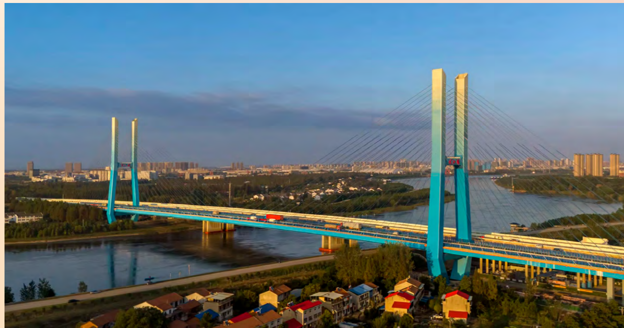
国家“十四五”重点工程和交通强国示范项目——二公院作为设计联合体牵头人设计的京港澳高速湖北北段改扩建工程顺利通过交工验收
