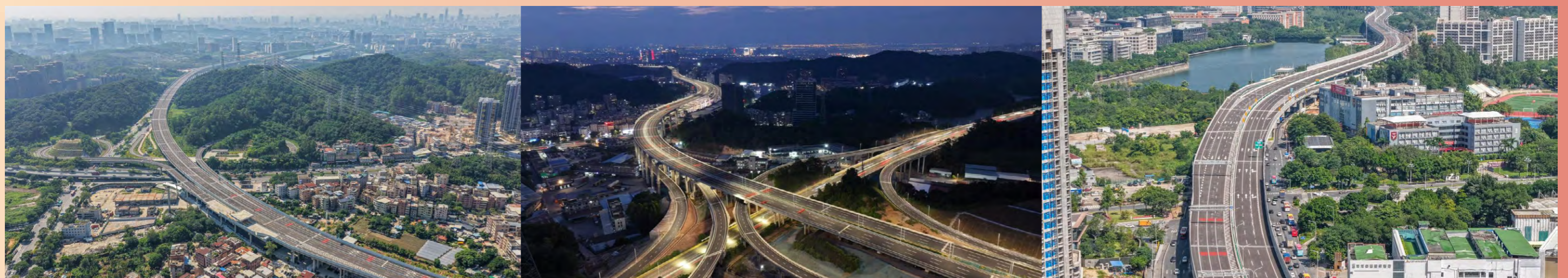
公规院主持设计的广州新白云国际机场第二高速公路南段工程建成通车
