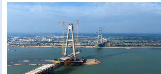
二公院设计的当枝松高速枝江长江大桥桥塔成功封顶
