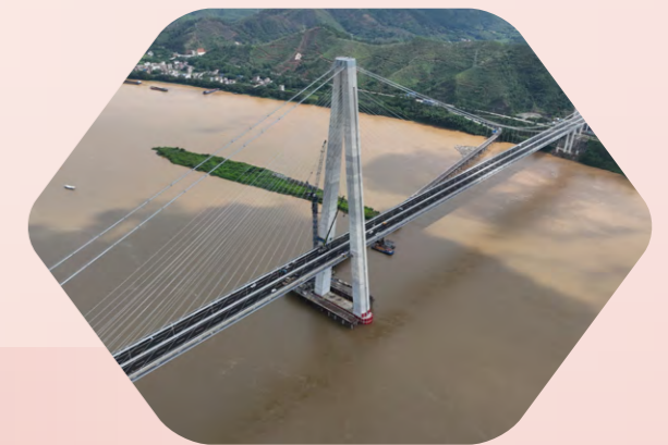
公规院主持设计的世界首座独塔斜拉—悬吊协作体系桥 ——藤州浔江大桥顺利通车
