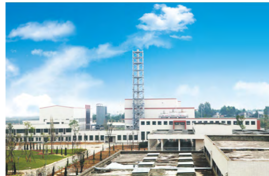
西南院设计的西南地区最大污泥单独焚烧项目——成都市第一城市污水污泥处理厂三期工程正式投产
