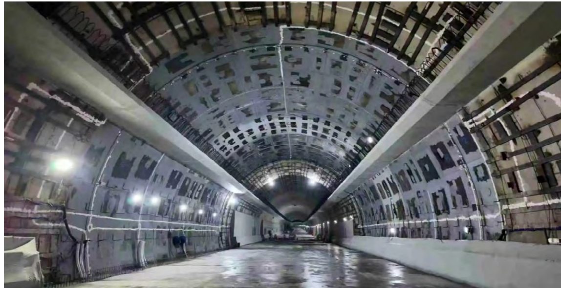
二公院参与技术咨询的江阴靖江长江隧道实现“江底对接”
