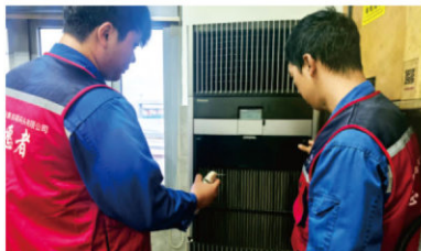
青年志愿者开展码头桥吊电缆沟清淤疏通、大型机械空调清洗等。
