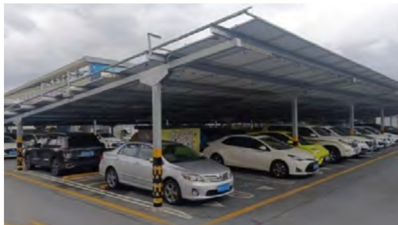
停车场屋面光伏铺设
