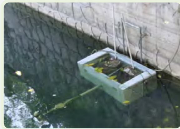
自主研发的水面垃圾收集站自动清理漂浮物 针对落叶等水面垃圾问题
