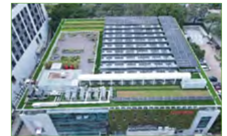
铺设屋顶光伏
