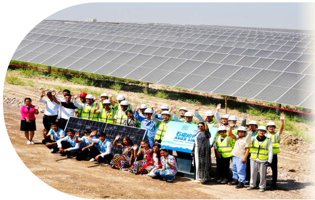
乌兹别克斯坦布卡光伏项目成功实现全容量并网发电，刷新乌兹同类大型光伏项目建设新纪录。
