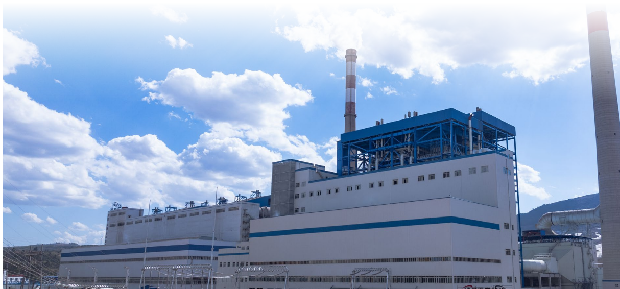
世界首台700兆瓦超超临界循环流化床锅炉正式投运，成为滇南区域最大的稳定电源支撑点
