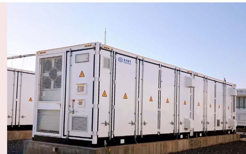
自研构网型PCS储能变流器实现首台（套）应用
